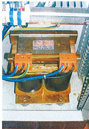
Figura 3 - Trasformatore di isolamento
