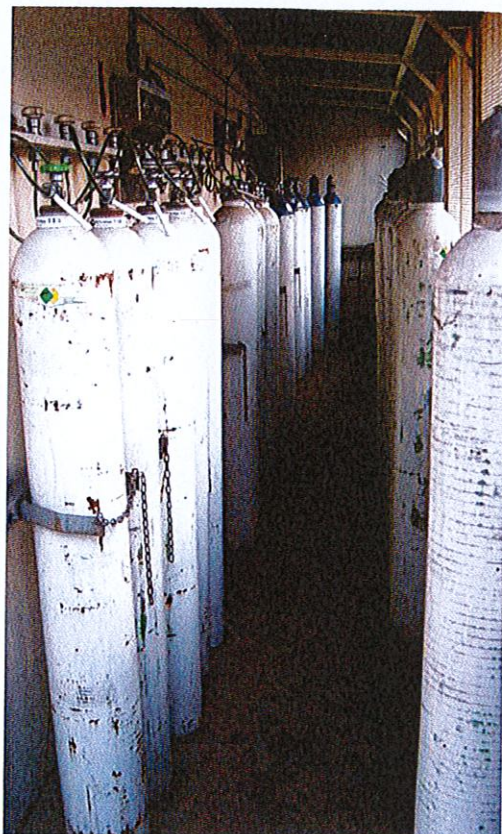
Batteria di pacchi bombola presso la Centrale di stoccaggio di protossido d'azoto della Casa di Cura Ruggiero di Cava de' Tirreni (SA)
