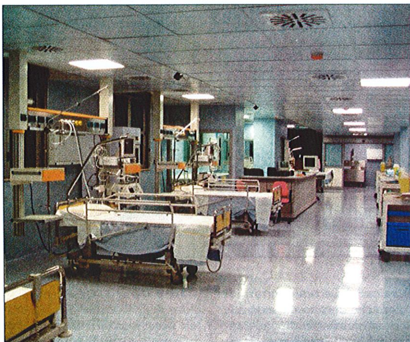
Figure 2 e 3 - Per l'illuminazione generale si può ricorrere a un'illuminazione a soffitto, mentre per le visite e i trattamenti s'impiegano in genere sorgenti luminose comprese in travi testa-letto o travi-pensili e/o alettoni pensili
