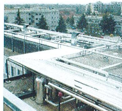
Nel caso dell'impianto di condizionamento a tutta aria esterna, questa, prima di essere inviata negli ambienti da condizionare, viene trattata mediante diverse Unità di Trattamento dell'Aria
