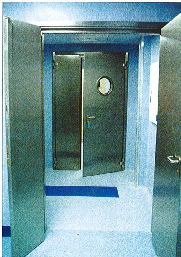
Al reparto operatorio si accede mediante una zona filtro che separa una zona dall'altra, sia procedendo dall'esterno alle sale operatorie sia in senso inverso
