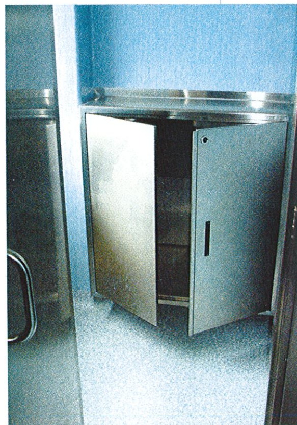
Il materiale sporco passa direttamente dalle sale operatorie, attraverso appositi cestelli passa-sporco in acciaio inox, in locali dedicati definiti "depositi sporco"
