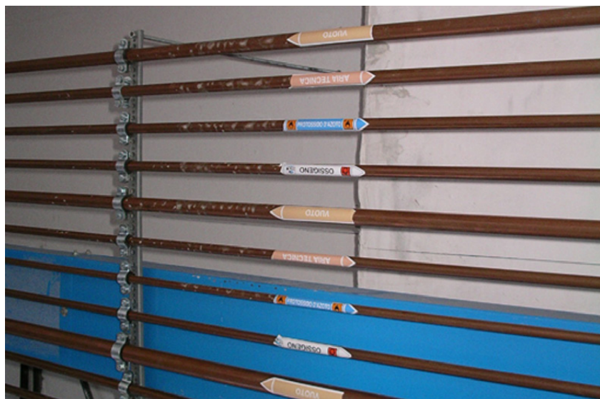
Impianti centralizzati di distribuzione dei gas medicinali
